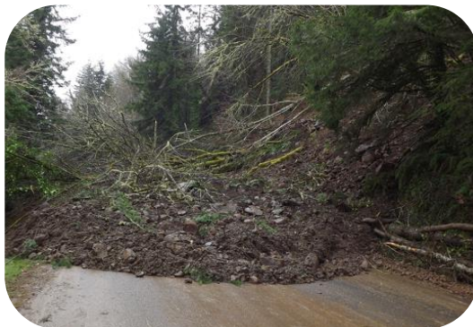
Odroni i klizišta
